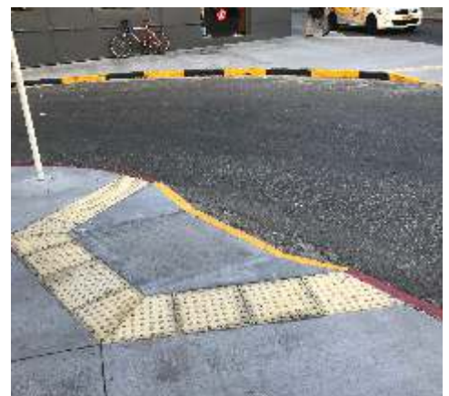
Foto 2: Ejemplo de la rampa de la vereda con tres caras para bajar y subir.
