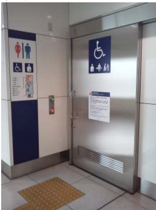
Foto 9: Ejemplo de señalización de baño accesible colocado o pegado a la pared o puerta.
