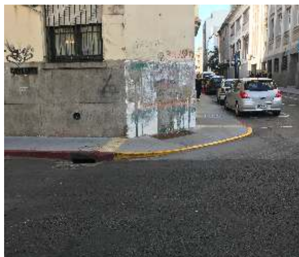
Foto 3: Ejemplo de la rampa para las veredas con rebajes de toda la esquina.
