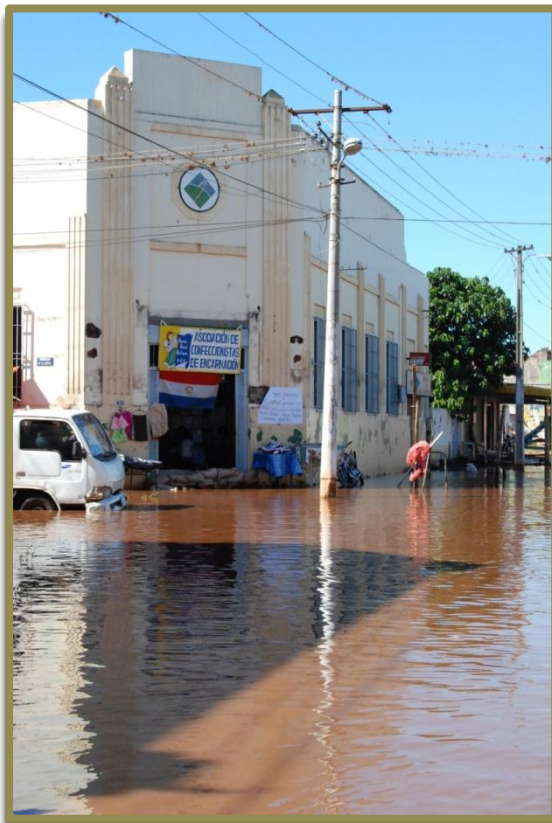
El edificio bajo agua, antes de su demolición.
