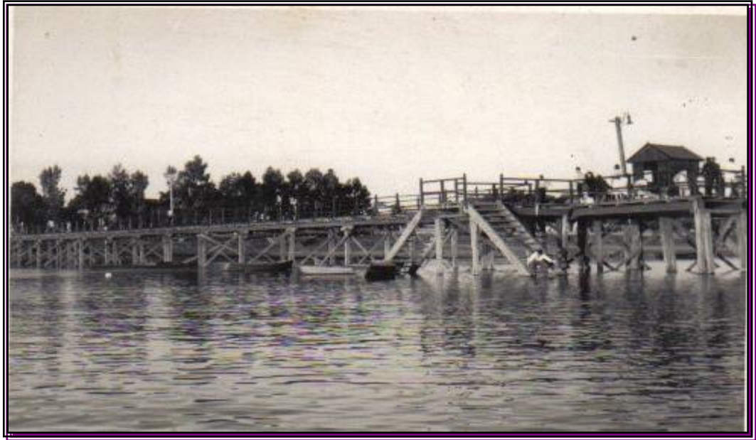
Muelle de madera construido después del ciclón
