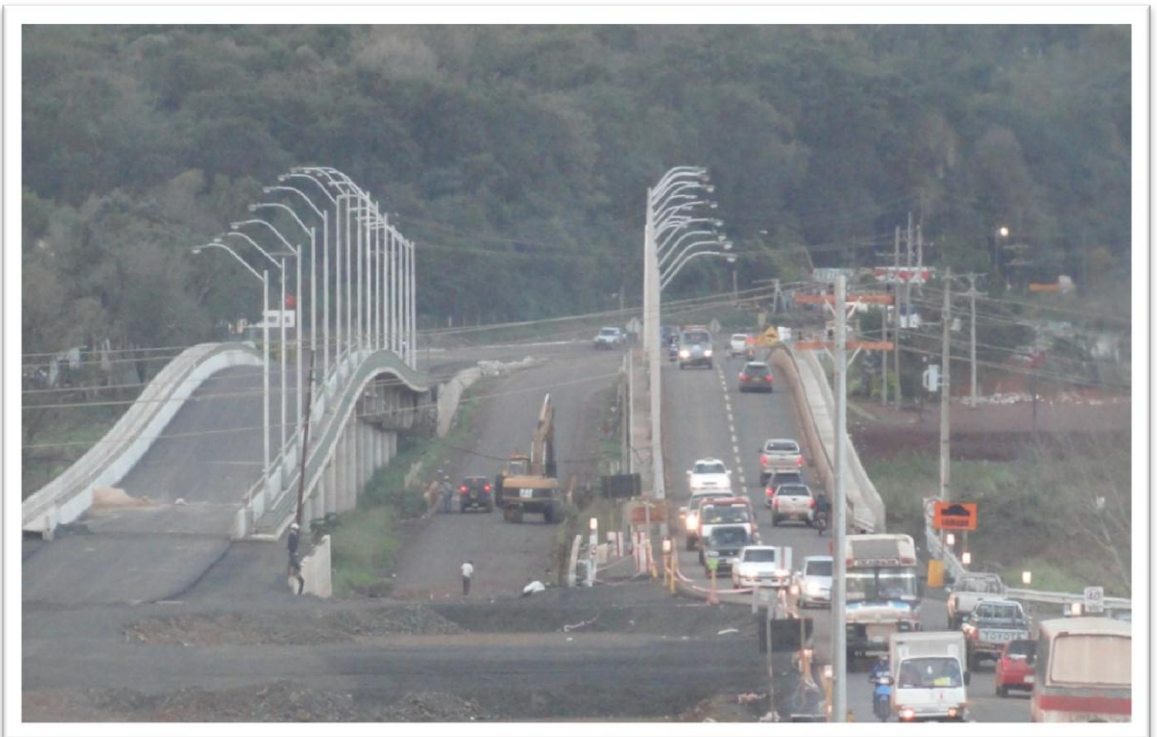
Puente sobre el arroyo “Santa María”
