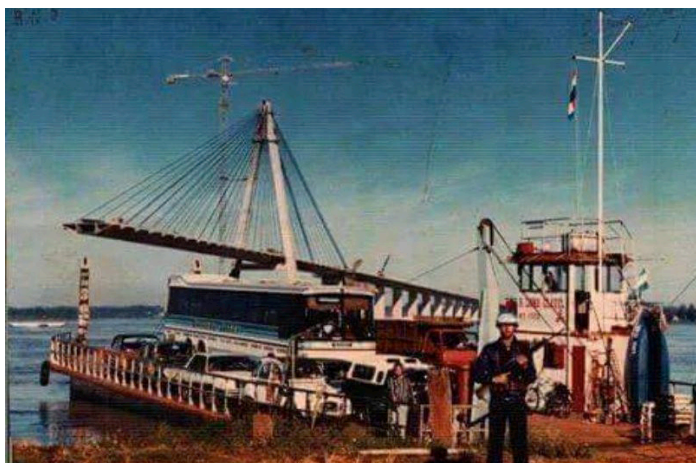
El Puerto de Encarnación, donde se visualiza la construcción del Puente Internacional San Roque González de Santa Cruz. Fuente: Arq. Andrés Morel.
